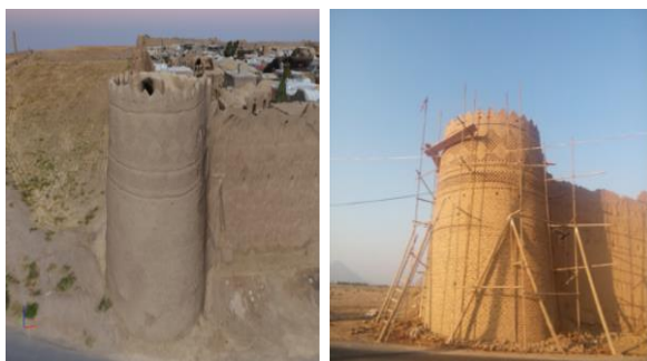
شکل ۱۲- استفاده از مدل سه بعدی در مرمت برج جنوب قلعه غربی دولت آباد
