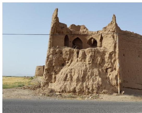
شکل ۹- برج جنوب قلعه غربی قبل از مرمت
