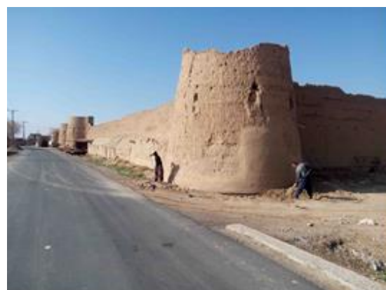
شکل ۴- نمای برج جنوب شرقی قلعه دولت آباد
