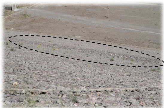
شکل ۳- نمایی از برآمدگی و تغییر شکل در پایین دست سد طالقان
