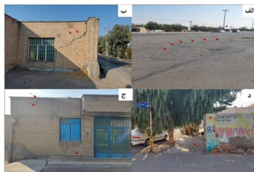
شکل ۱۰- آثار فرونشست زمین بر زیرساخت شهری
